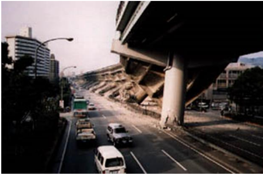
阪神高速道路倒壊
